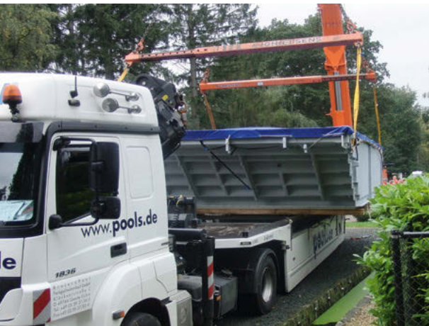
Un travail ad hoc : la coque vous arrive de l'usine déjà carrelée
